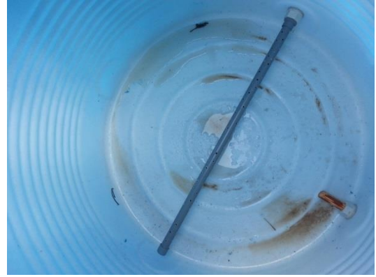
Bể nước đã lắp ống
